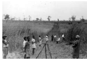
Colocação dos tripés ao longo da base e nivelamento
