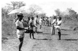
Colocação dos fios sobre os tripés e peso tensor
