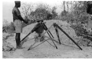
Colocação dos tripés ao longo da base e nivelamento
