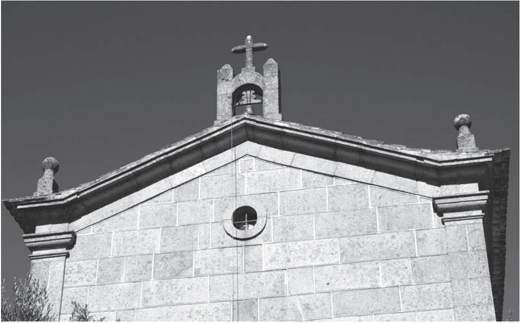
Imagem 2 – Fachada principal da capela da Quinta. Fotografia de João Silva.
