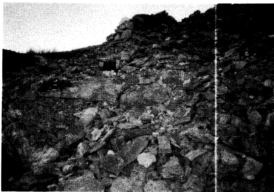
2 - Fraga do Castelo - pormenor do derrube do torreão.
