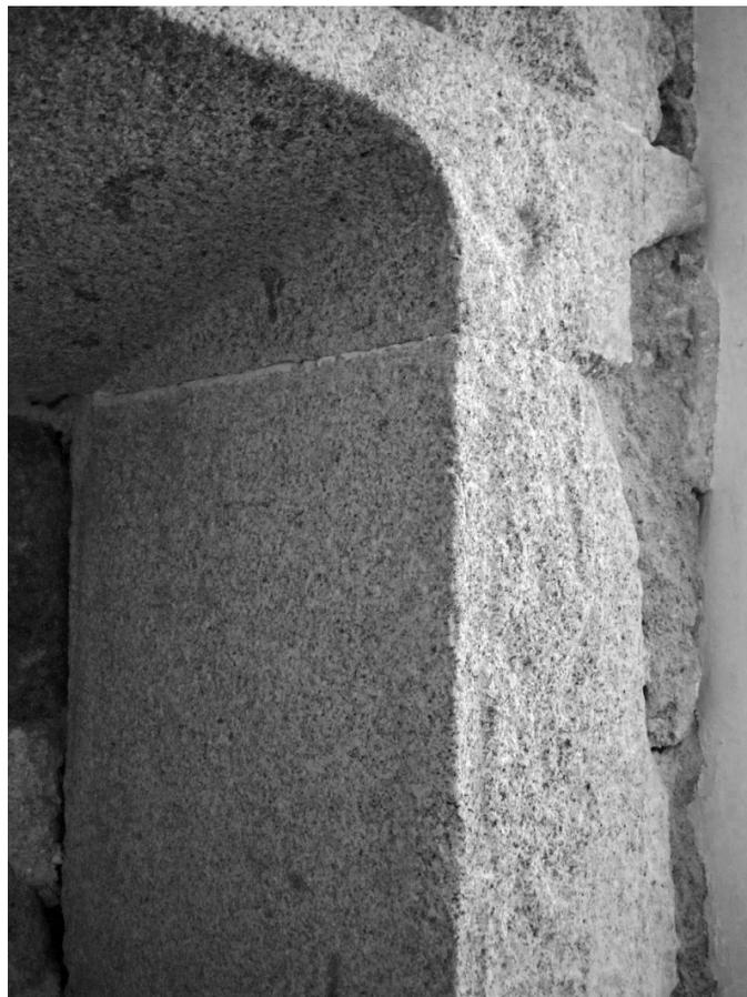
**Fig. 15** – Vão inferior do *hekhal* do Porto com topo inclinado e peça mesial chanfrada.
