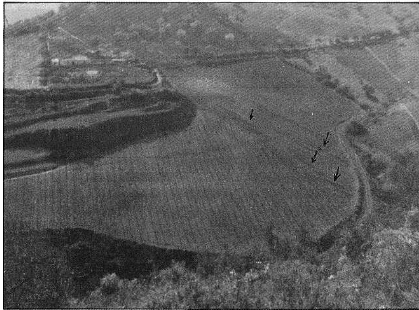
FoL 10 — Margem W do vale do ribeiro das Águas. Casal Novo da Charneca. Vinha plantada perpendicularmente ao traçado das curvas de nível. As setas indicam localização dos abarrancamentos representados na fotografia 9.
