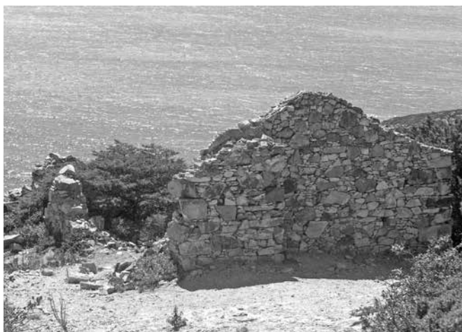
Figura 13 – Ruínas da mesma estrutura (vista para Sul).
