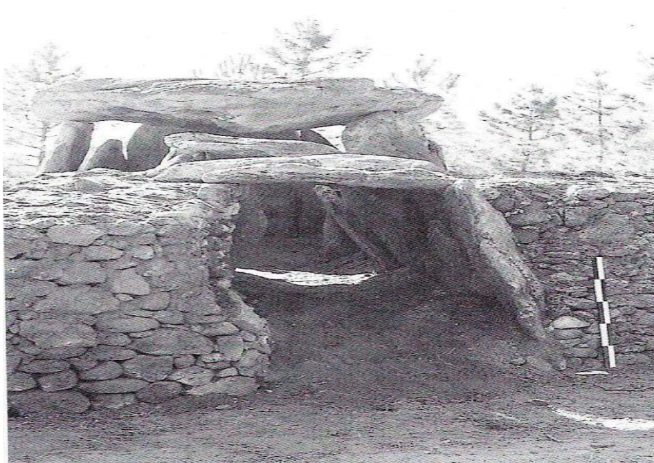
Figura 5 - Vista da câmara, do corredor e do muro de suporte à Mamoa/Dólmen 1 da Cerqueira, após a finalização dos trabalhos de restauro e consolidação de 1988.
