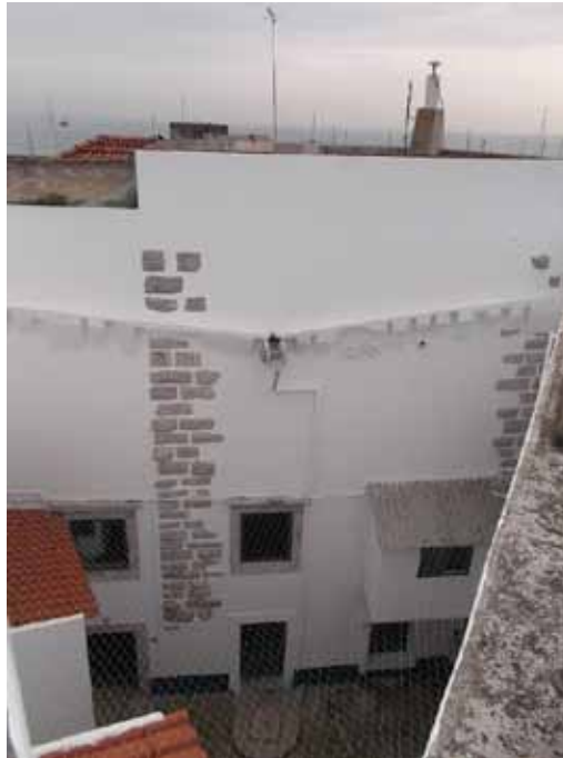
Figura 6 – Pormenor dos cunhais de cantaria que delimitavam a face Norte da torre de Cascais (foto: Marco Oliveira Borges).
