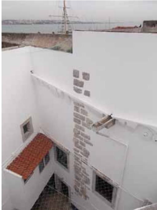
Figura 7 – Outro pormenor dos cunhais de cantaria que delimitavam a face Norte da torre de Cascais (foto: Marco Oliveira Borges).
