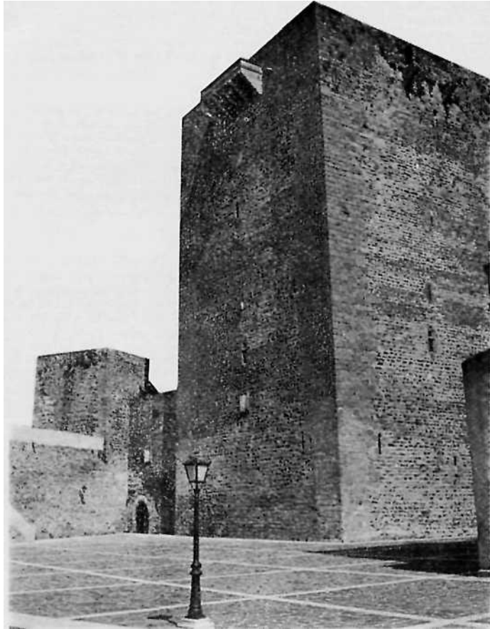
Fig. 1 — Torre de menagem do Castelo de Olivença.
