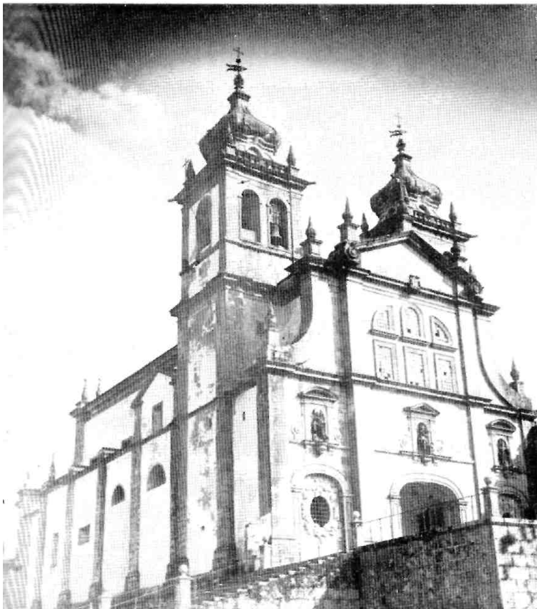
Fig. 1 — Um aspecto do frontispício e flanco Norte da Igreja da Abadia de Tibães
