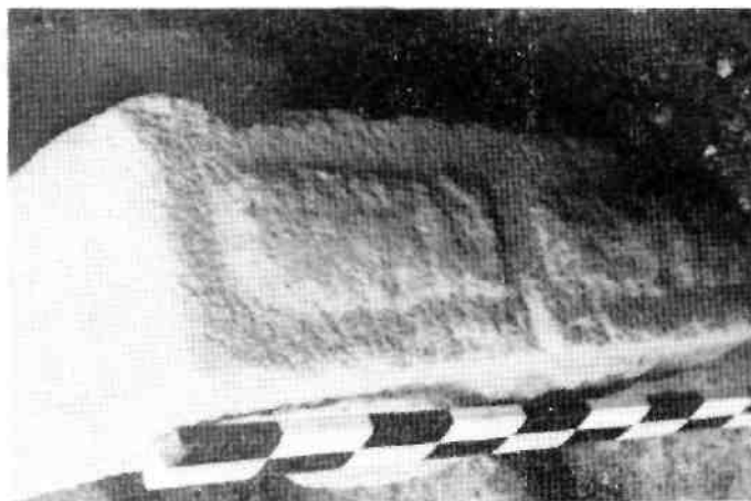
Fot. 2 — Pedra romana, almofa- dada, aproveitada no alicerce do edifício
