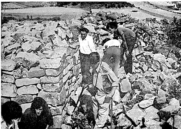
Fig. 18 — Outro aspecto dos trabalhos junto do cunhal interno da porta de sw. A face interna da muralha estava muito inclinada, ameaçando ruir. Foi reconstruída, desde a base, numa extensão de cerca de seis metros.
