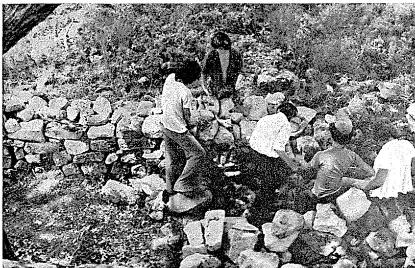
Fig. 27 — Trabalhos de reconstituição de um muro que, a Oeste, limita a passagem estreita ou corredor de acesso à zona central do Castro.
