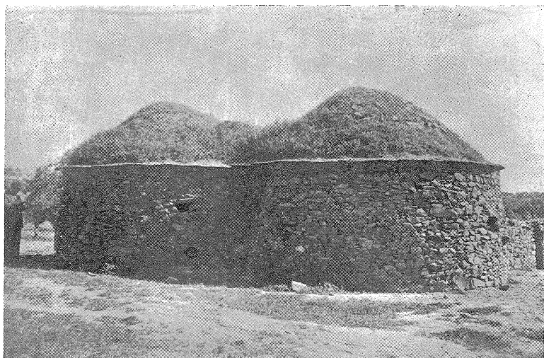
Construções circulares com abóbada falsa de Barrancos (Monte Grande).
