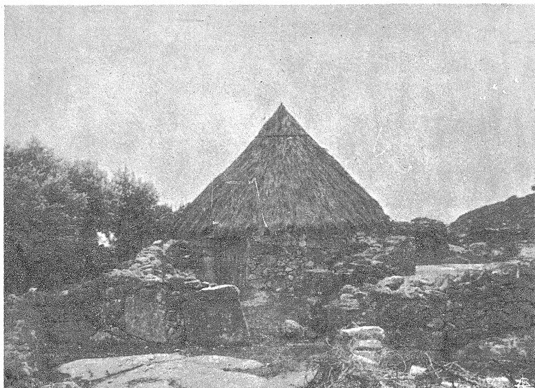
Casa cilíndrico-cónica da aldeia dos Cabeçudos (Marvão). Reparar no vestíbulo de pedra que recorda os da Citânia de Briteiros.
