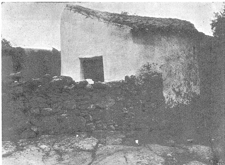
Casa recente de planta circular, da aldeia dos Cabeçudos (Marvão). Construção derivada das cilíndrico-cónicas, mais antigas na região.
