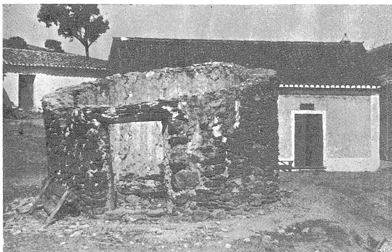
Casa em Pedralva (Aljezur). Foi habitada antigamente. O telhado duma só água foi há pouco desfeito.
