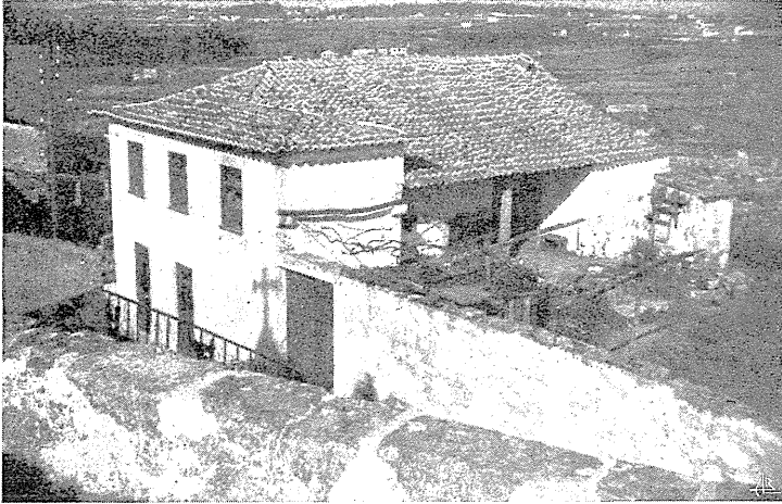
Fig. 1 — Casa em Espozade — Tipo intermediário entre A' e B: pelo aspecto da sua fachada sobre a rua, parece uma casa do tipo B; o andar porém resulta do desnível do terreno, e, para trás, a casa é térrea; vêem-se os dois cubículos, recobertos, um, pela ala lateral e o outro pela água maior do telhado, e o alpendre que corre entre eles, característicos das casas dos tipos A'.
