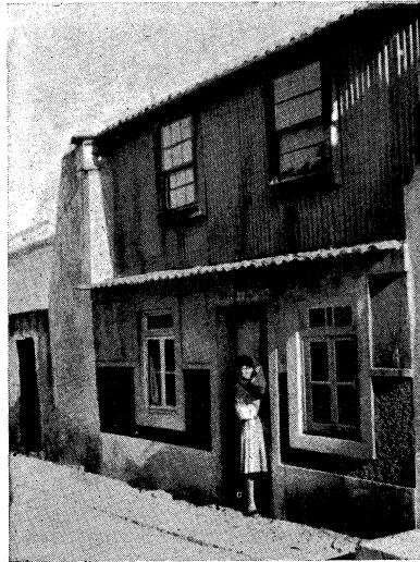
Fig. 10 — Em lugar do «mirante» a meio, a parede corre de lado a lado da casa, um pouco recuada do beiral. (R. da Lapa, 25).
