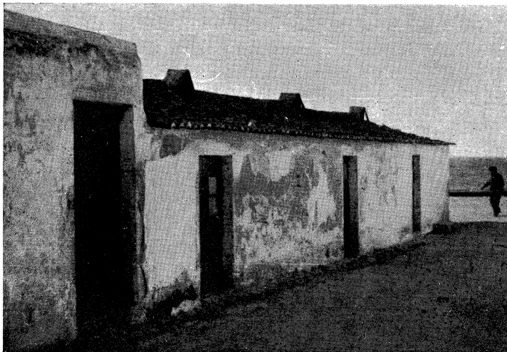
Fig. 3 — Velhas casas de pescadores, com o telhado, por excepção, a uma água só. (Trav. da Caverneira).
