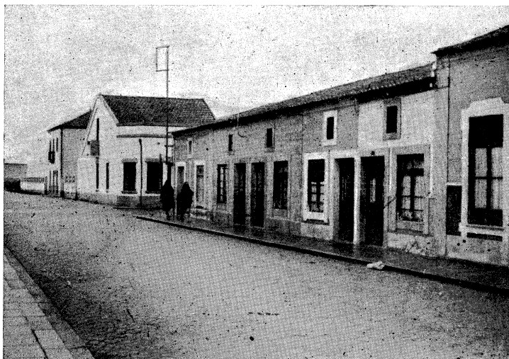
Fig. 7 — Casas com postigos de iluminação do falso. (R. António Graça, 140/152).
