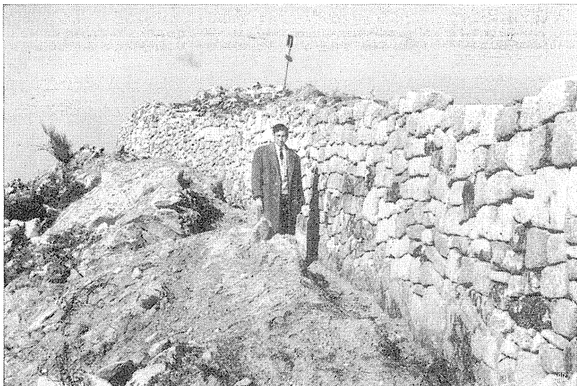
Fig. 4 — Troço da muralha do lado poente. Na fotografia vê-se o Professor e Delegado Escolar Sr. Manuel Alfredo Marques, que, sob nossa orientação, tem dado seguimento às escavações.
