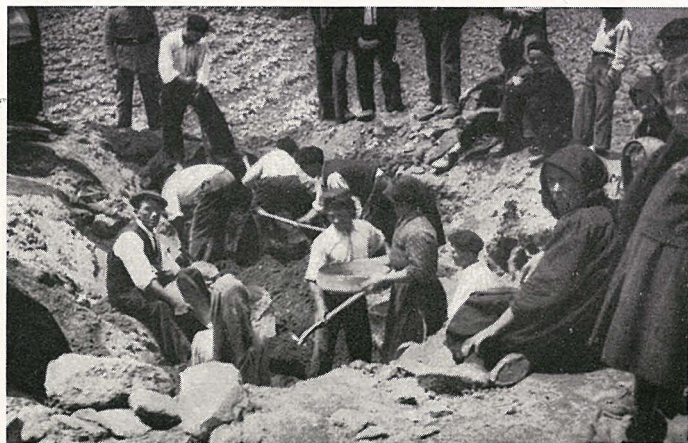
Fig. 90 — Escavação da câmara circular onde apareceu o berrão de Picote, e início do corredor.
