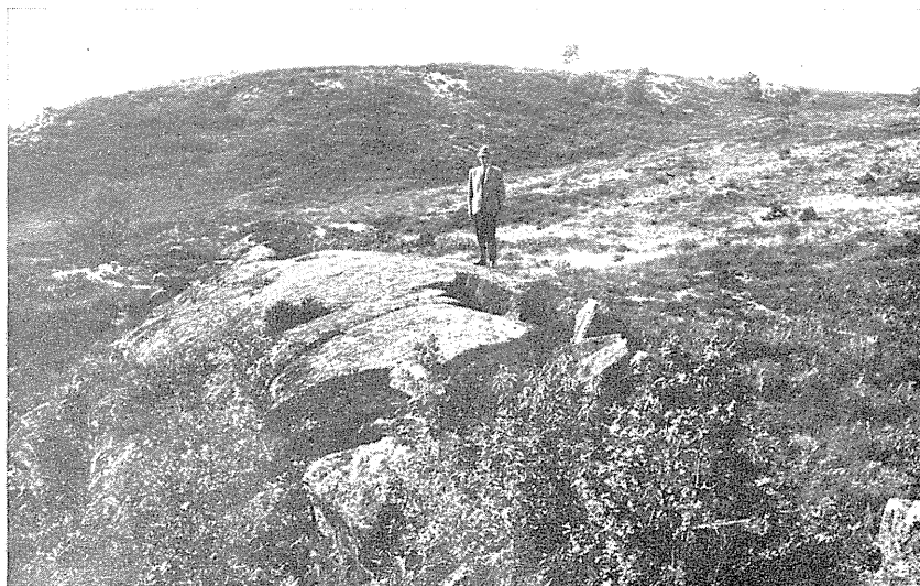
Fig. 15 — O topo do lado norte do Outeiro Machado que foi quebrada a dinamite.
