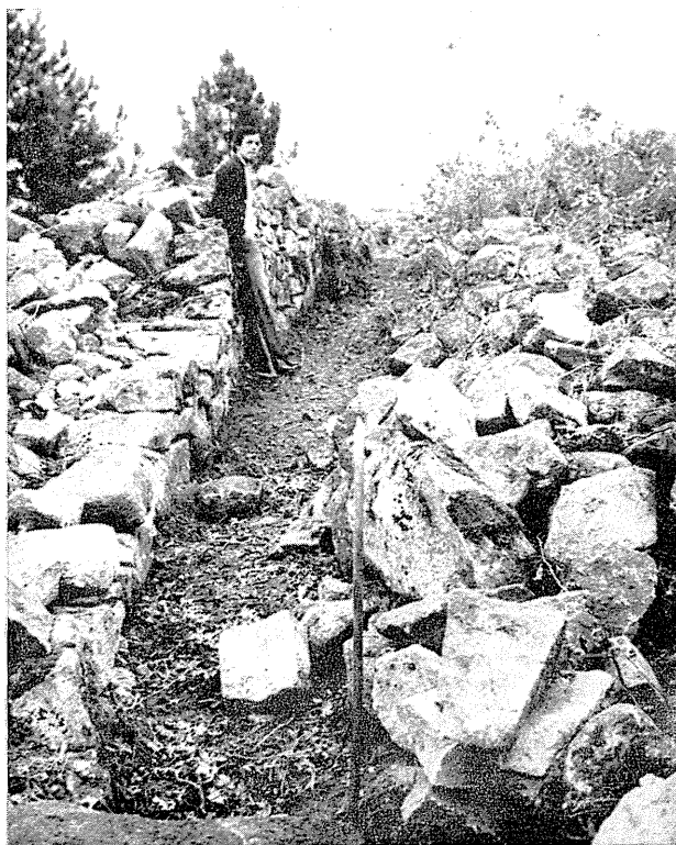
Fig. 4 — Aspecto da face interna da muralha para nascente da porta do lado norte.
