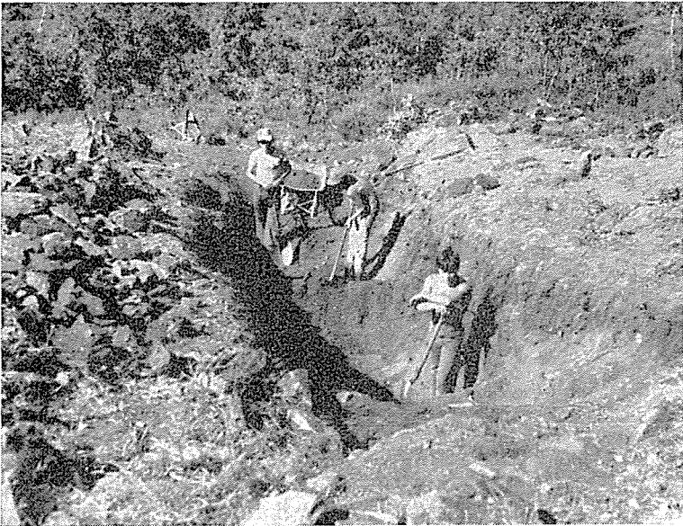
Fig. 4 — Escavação do 2.º fosso na parte cimeira e a seguir à faixa da rocha xistosa que o atravessava. À esquerda as pedras que com terra negra faziam o enchimento do fosso.
