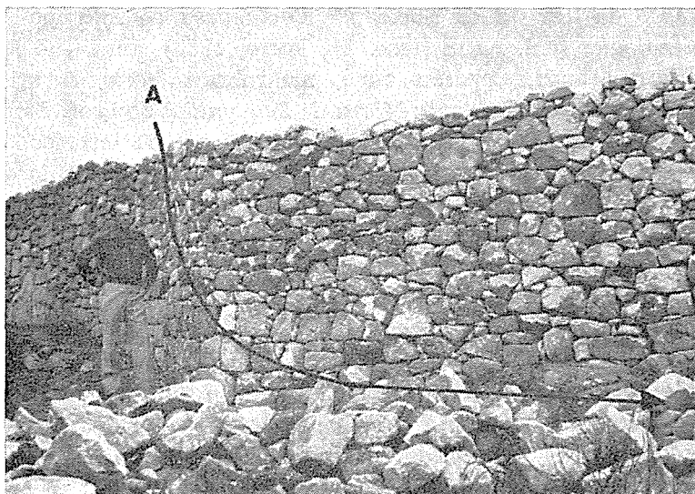
Fig. 4 — Troço da muralha cimeira que havia derruído e foi reconstruída numa extensão de 6,5 m de comprimento por 2,5 m de altura.
