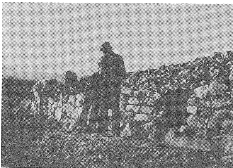
Fig. 6—Um aspecto dos trabalhos de reconstrução da muralha central entre as portas E e N.
