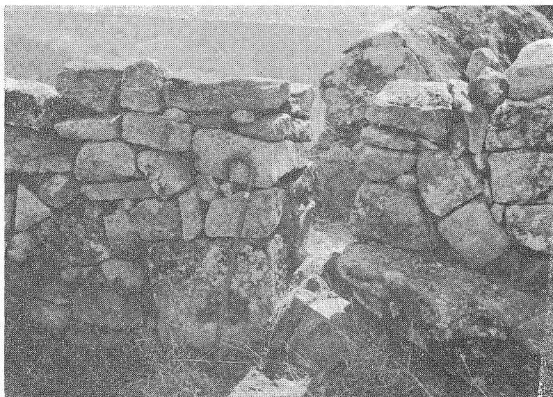
Fig. 22 — Portelo de acesso ao alto dos penedos adjacentes pelo nascente, ao pinheiro manso. Portelo que foi reconstruído por terem sido parcialmente derribadas algumas pedras. A bengala mede 82 cm.
