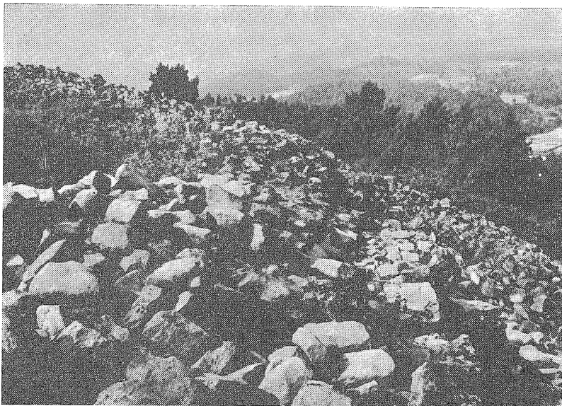
Fig. 5—A muralha central, entre as portas E e N, no início da fase de reconstrução.
