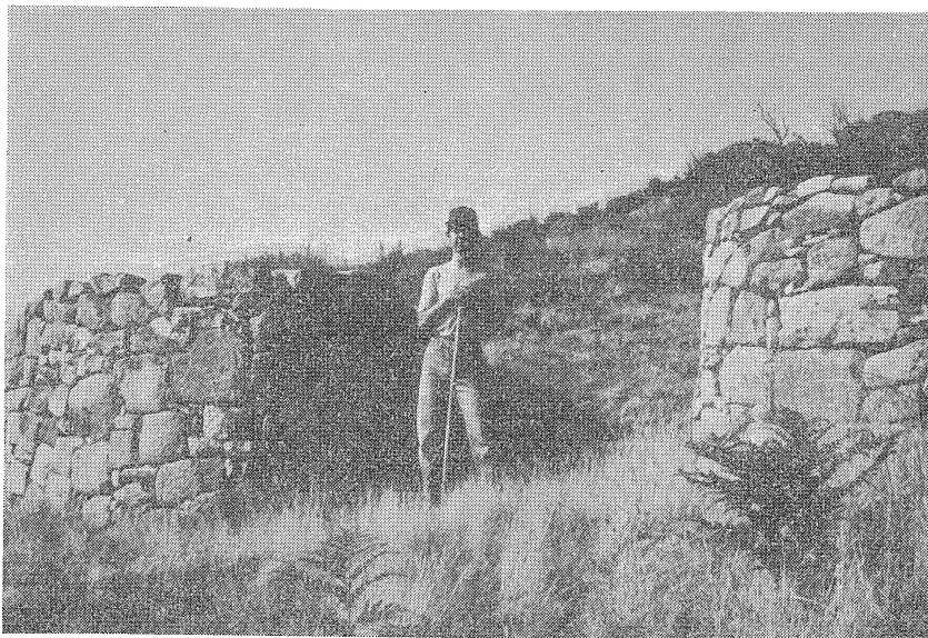
Fig. 5—Um aspecto da porta restaurada na 2. a muralha, no seu troço virado a nascente e fotografado pelo lado de fora da muralha.
