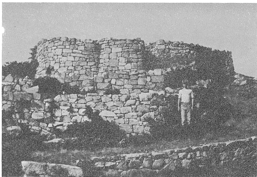
Fig. 2 — Aspecto do torreão do castro, fotografado pela parte de dentro do reduto cimeiro.
