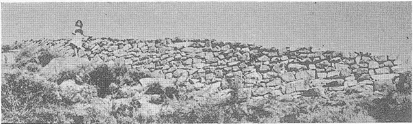
Fig. 4 — 1. a muralha, restaurada no seu flanco sul.
