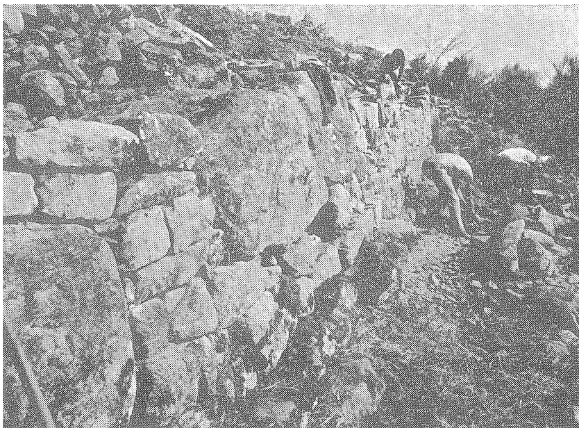
Fig. 6—Aspecto do troço da 2. a muralha, a SE, a que se refere a fig. 5, depois de ter sido reconstruída até uma altura de cerca de 2 metros.
