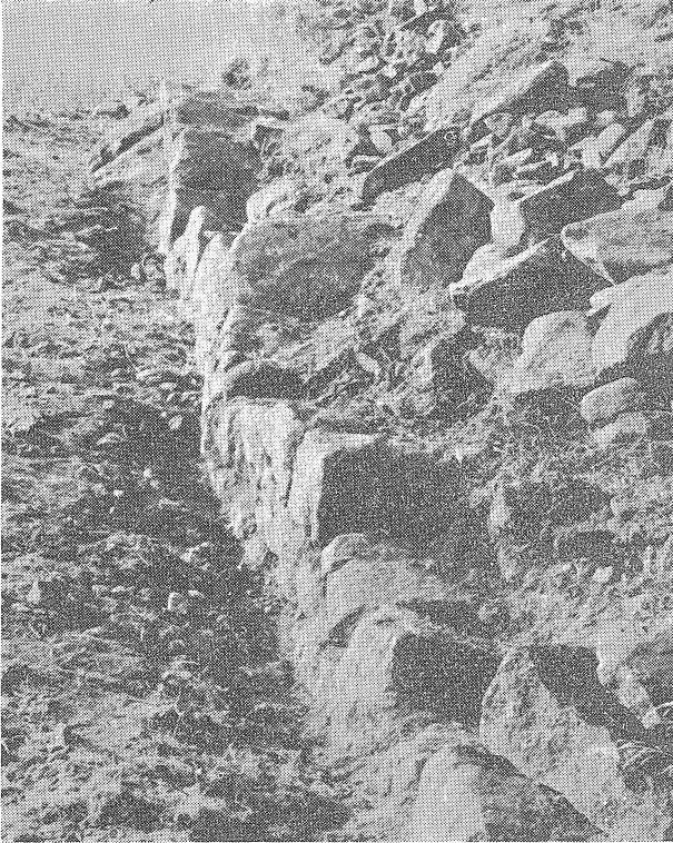
Fig. 7 — Base da 2. a muralha em frente à porta E da muralha central, depois de ter sido posta a descoberto. Foi necessário, aqui, remover grandes quantidades de pedras e de terra, trabalho muito dificultado pela presença de uma densa rede de raízes de plantas.
