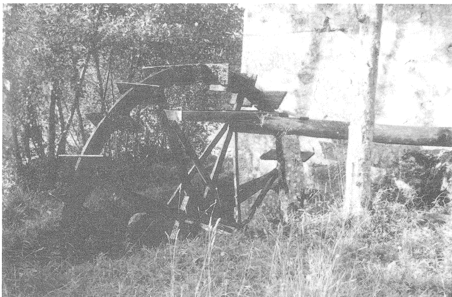
Fig. 3 — Vilela, Arcos de Valdevez. A roda de elevar água para alimentar a caldeira.
