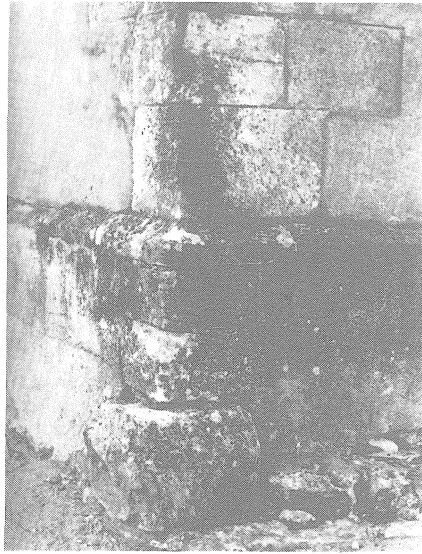
Fig. 1 — Pormenor da base da torre sineira, assente num maciço argamassado.
