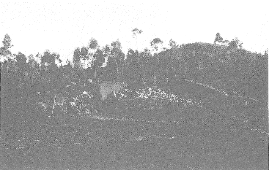
Fig. 2 — Mamoa 1 de Carvalho Mau (Castelo de Paiva): vista geral do monumento, com evidência da estrutura de contrafortagem.
