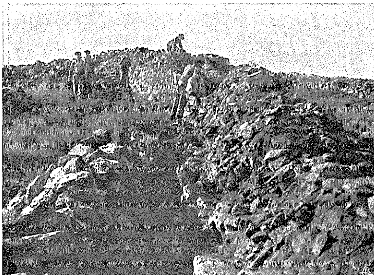
Fig. 20 — Reposição das pedras caídas junto da muralha. No 1.º plano, e a meio desta fotografia, nota-se o encurvamento da muralha que ali mete a quarta rampa do alinhamento do noroeste.
