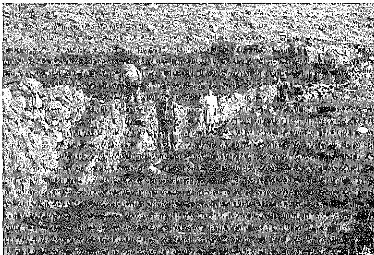
Fig. 24 — Rampas de acesso à muralha no alinhamento de noroeste.
