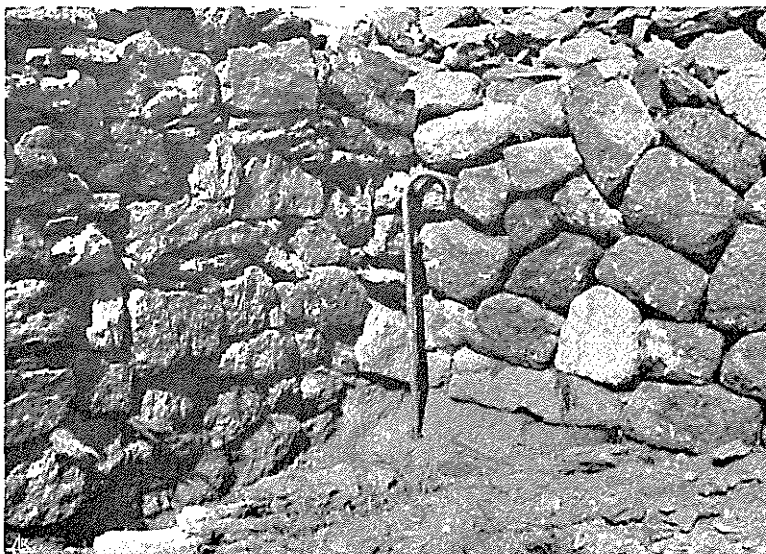
Fig. 23 — À esquerda porção da muralha exterior feita de xisto. À direita muralha de granito do topo arredondado ou cubelo, junto da porta do castro. Ver fig. 3.
